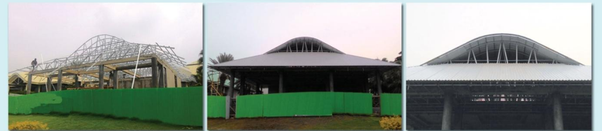
Atap melengkung menggunakan struktur Rangka Atap Baja Ringan / Truss.
