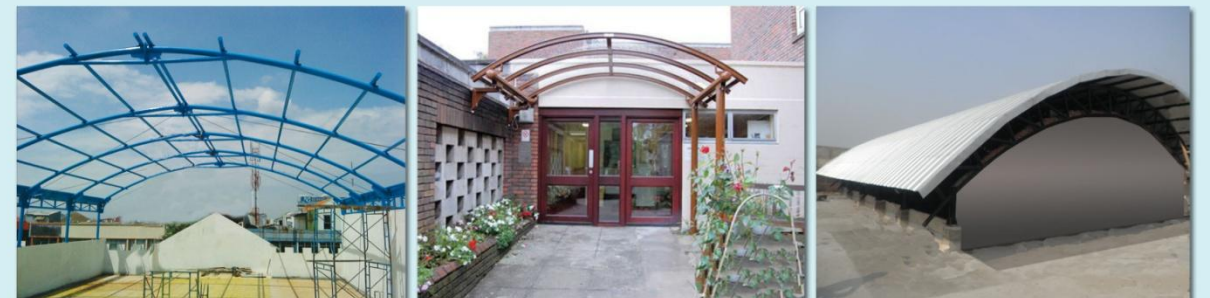
Atap melengkung menggunakan struktur Baja Konvensional (Besi Pipa).
