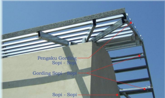
PEMASANGAN PERKUATAN PADA AREA TERITISAN SOPI - SOPI
